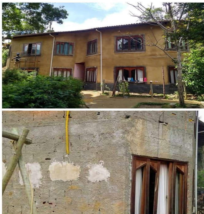
Figura 7: Emboço da EMCM
